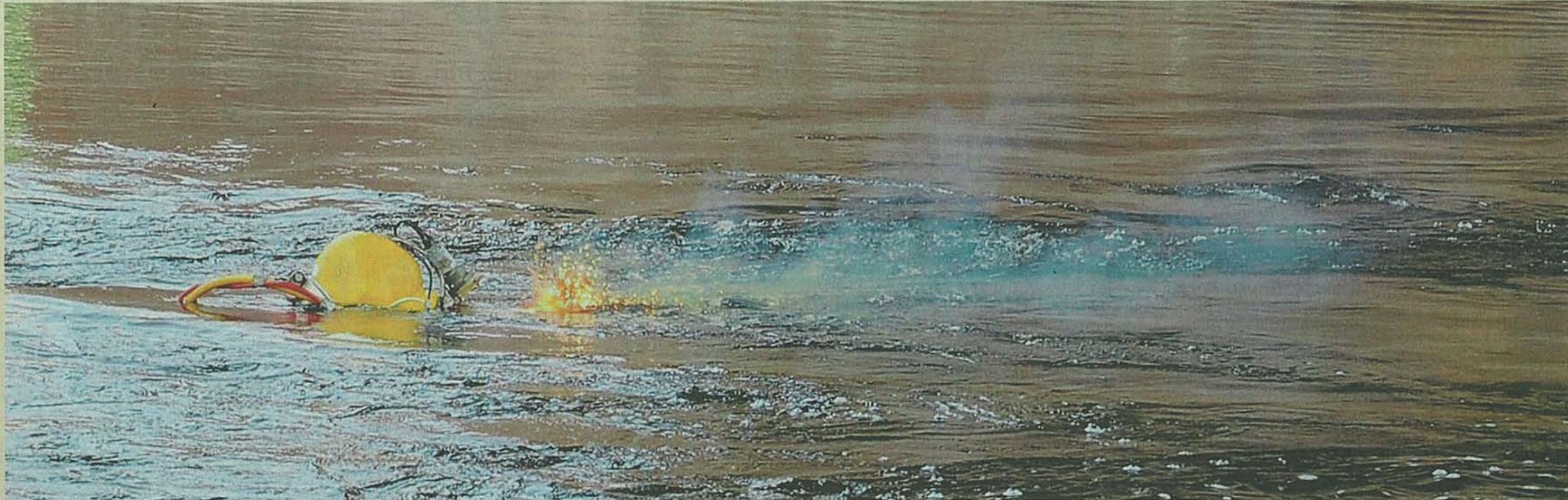
**Feuer unter Wasser:** Hier ist kein Taucher mit der olympischen Fackel baden gegangen. Das ist Präzisionsarbeit an der Pöppelmannbrücke in Grimma. Das Spezialteam Michael Scheide und Axel Lindemann ist in die Mulde abgetaucht und brennt unter Wasser Spundwände aus Stahl ab, die bereits 1999 zur Pfeilersanie-
