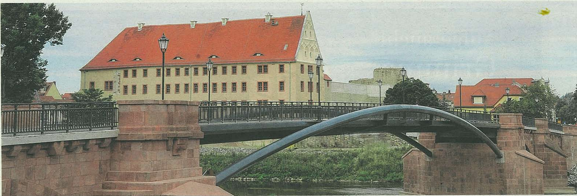
Die Pöppelmannbrücke erstrahlt in neuem Glanz und mit neuem Gesicht. Zukünftig wird beispielsweise die Brücke nur noch von vier Pfeilern getragen.
