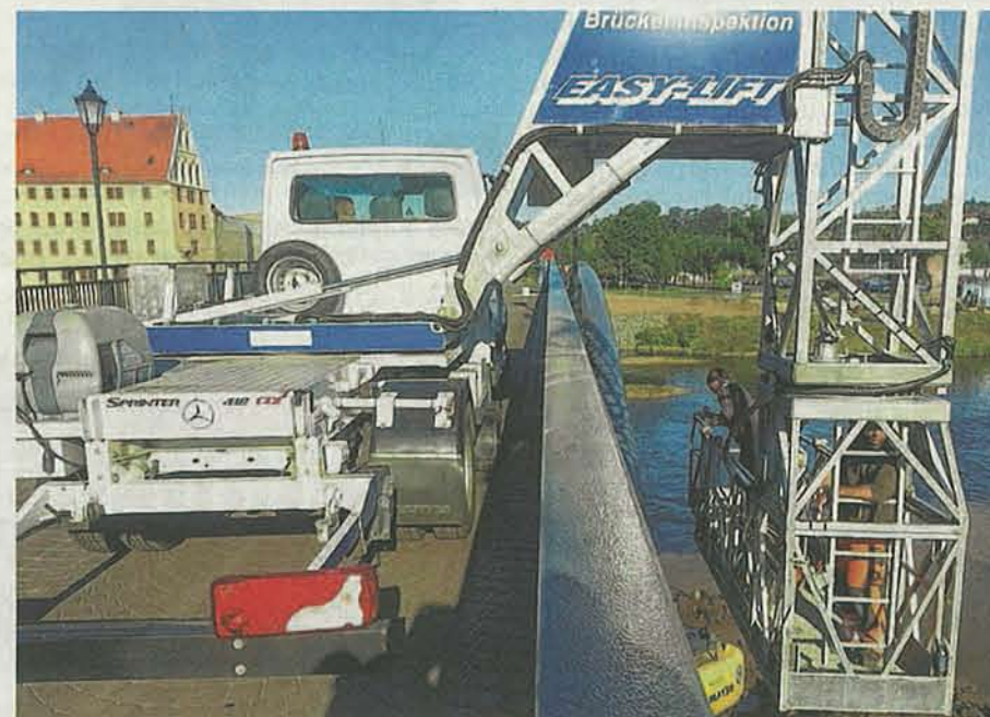
Der Blick von außen: Spezialisten wie Thomas Wuhnnow (vorn im Korb) und Karsten Eins (hinten) einer unabhängigen Prüffirma inspizieren die Brücke von allen Seiten.
