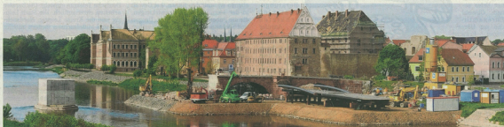
Baugeschehen in großem Maße: Über die Maßnahmen und Zeiträume können sich die Grimmaer und die Besucher nicht vor Ort informieren.
