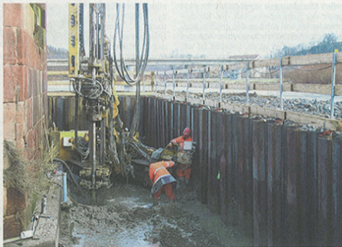
Unter der Wasseroberfläche: Markus Börsch (r.) und Dominik Müller befestigen den Boden rund um den Brückenpfeiler. Foto: André Neumann
