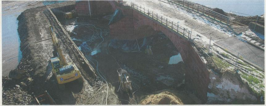
Brückenbau in Grimma aus der Vogelperspektive: In einer trocken gelegten Grube stabilisieren Bauleute des Spezialtiefbauers Bilfinger Berger derzeit den Untergrund um die
