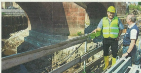
Blick auf die große, mit Spundwänden eingefasste Baugrube: Andreas Apelt (l.) von der Bauberleitung und Hartmut Gühlmann von der Grimmaer Stadtverwaltung.
