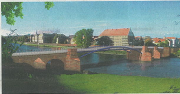
65 Meter langes Mittelteil aus Stahl: So wie auf dieser Computergrafik soll die neue Brücke aussehen. Im Hintergrund ist die Hochwasserschutzmauer angedeutet. Grafik: GUB
